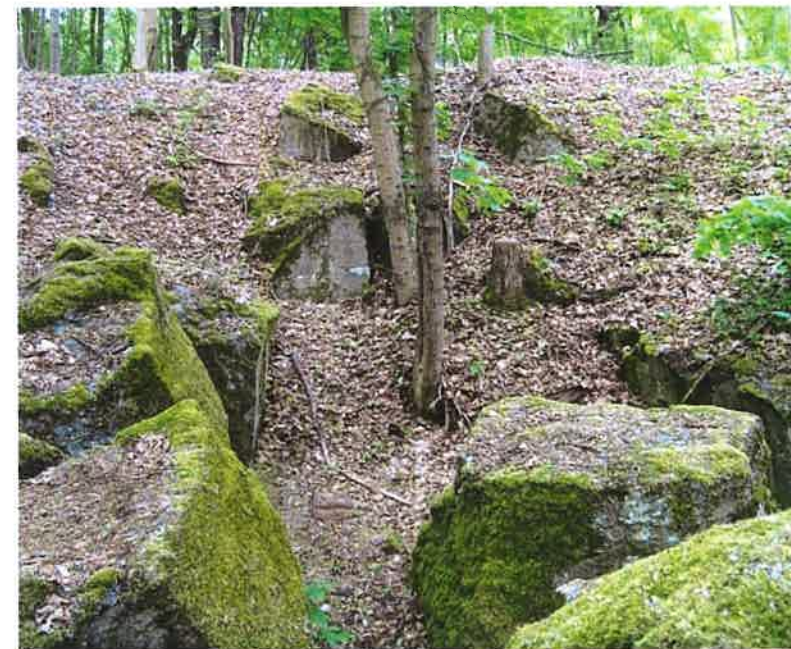
Fot. 21. Widok od zachodu na wnętrze schronu (2e): na pierwszym planie fragmenty tylnej ściany i sklepienia, za nimi zasypane częściowo wnętrze i popękane ściany – boczne i na wprost czołowa, ze śladem łuku sklepienia, wokół rozrzucone fragmenty sklepienia. Widać duże zagłębienie schronu względem szczytu wzniesienia.
