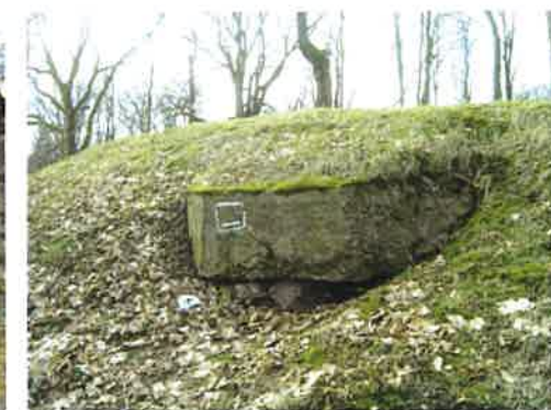
Fot. 32. Schron (3b), widok z płn. wschodu. Widoczne wieloboczne zakończenie i brak narożnego fragmentu ściany czołowej.
