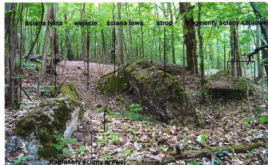
Fot. 11. Schron bojowy dla ckm (2a), widok ogólny na ruiny wysadzonego obiektu od południowego wschodu.
