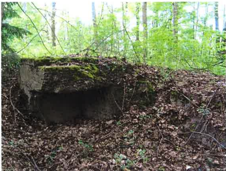
Fot. 10. Stanowisko (1k) - ściany i fragment nakrywającego niszę stropu o konstrukcji żelbetowej, z widocznymi prętami zbrojenia, nieznacznie wystające nad ziemne przedpiersie rowu strzeleckiego.
