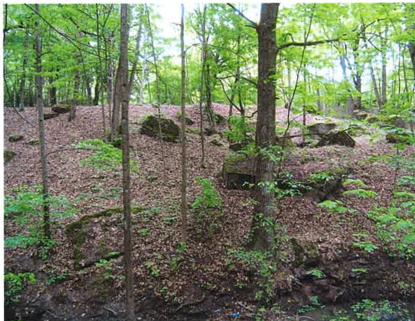
Fot. 20. Wysadzony schron bierny (2e) - widok od zachodu na rozrzucone wybuchem fragmenty sklepienia i tylnej ściany. U dołu kadru rów Kanalu Boryszewskiego, na wprost za drzewem duży fragment tylnej ściany z murem oporowym z charakterystycznym schodkowym fundamentem, za nim zagłębienie z pozostałością schronu, na prawo od niego kolejne fragmenty tylnej ściany.
