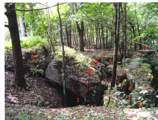
Fot. 24. Schron (2f), widok z północnego wschodu. Widoczny układ wnętrza (oznaczenia za ryc. 18 i fot. 22), fragmenty stropu (g, h, i; kółkiem zaznaczone ocalałe kłamy), po prawej stronie zachowana część ściany lewej i skośny mur oporowy (c).
